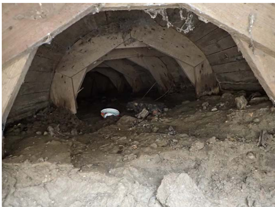
Obr. č.2 - Nátoková část propustku pod účelovou komunikací
