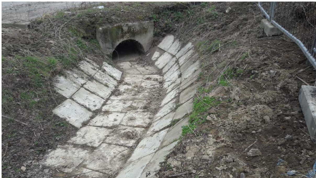
Obr. č.2 - Nátoková část propustku pod účelovou komunikací
