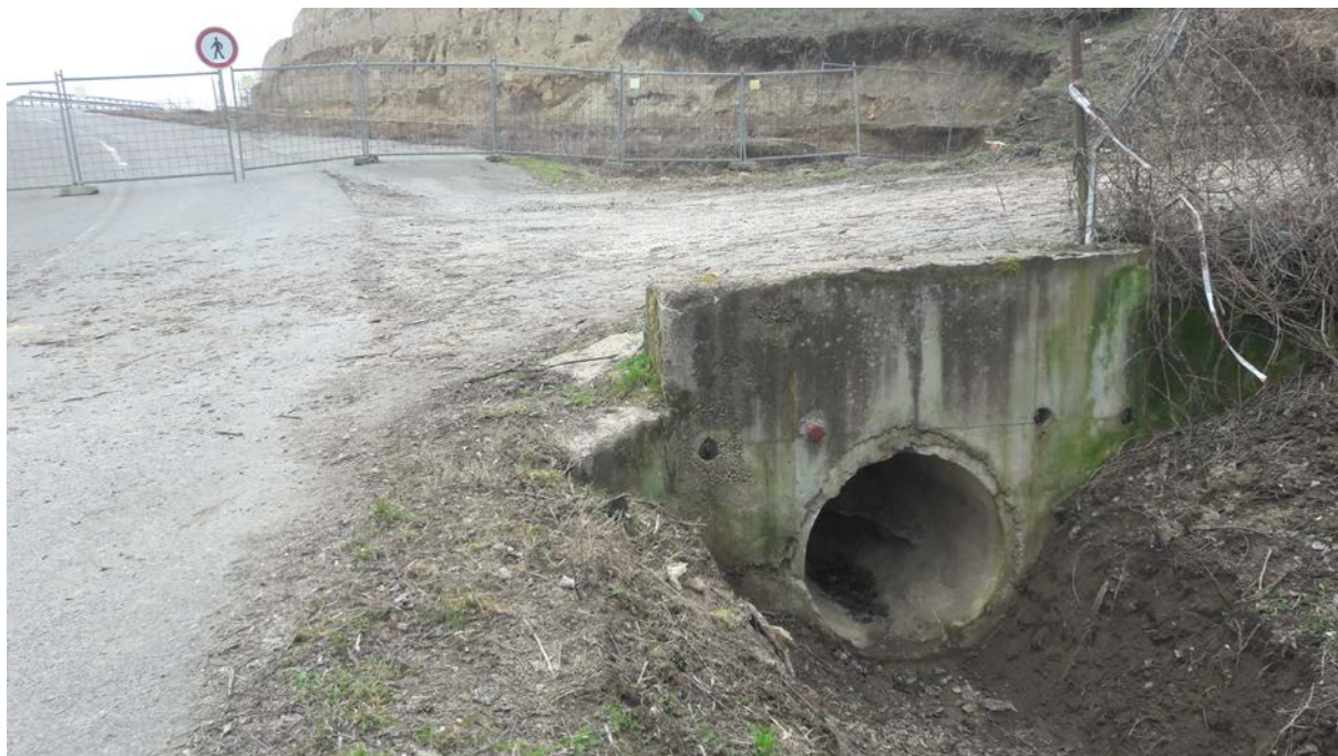
Obr. č.4 – Výtokové čelo propustku pod účelovou komunikací a navazující silniční příkop
